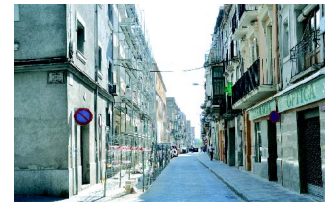
Ampliació de voreres i millores als carrers de General Cortijo, Cid, Pines, Sant Pere, General Vallès i avinguda de Barcelona.
