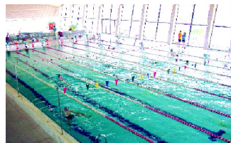
Ampliació i reforma del Complex Aquàtic de Vilafranca.
