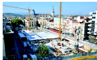
Aparcament soterrat a la rambla de Sant Francesc i nova urbanització de la rambla Sant Francesc.
